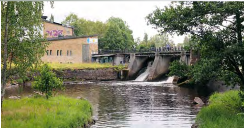
Strömdalens kraftverk i Gavleån. Här, endast 1,5 kilometer från havet, tar det stopp för fisken. Förr fanns både fiskväg och ålyngelledare på denna plats.
