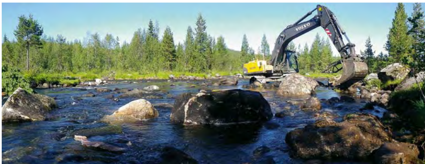
Stora stenar flyttas från land till vattnet. Foto Daniel Jonsson
