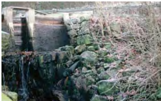
Uppströmsvy på kraftverksdammen i Skärte.
