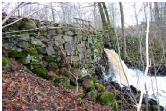
Hovgårdsdammen på nerströmssidan innan utrivningen 2006.
