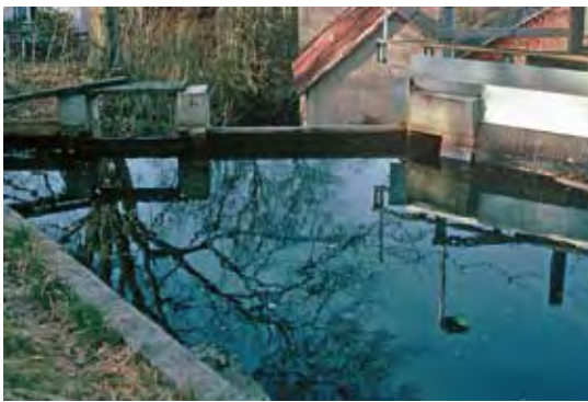
Kraftverksdammen i Himleån innan utrivningen 1999.
