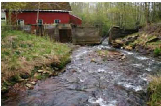
Kraftverksdammens luckor borttagna enkel åtgärd som ger så ohyggligt mycke.
