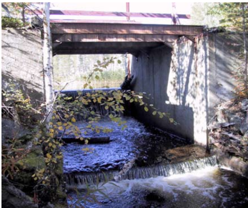
Damm vid Svanaträsket i Lögdeälvens vattensystem som kommer att öppnas upp för fiskvandring. Foto: Länsstyrelsen i Västerbottens län.
