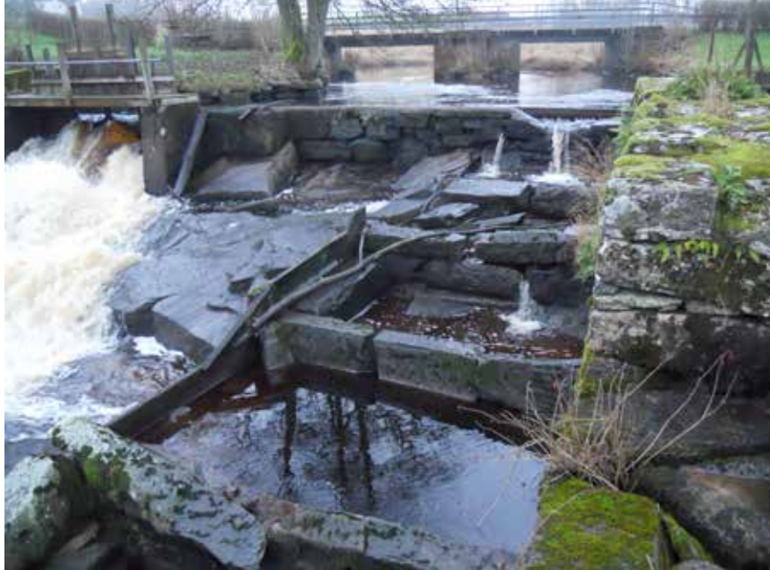
Fisktrappan vid Mølnebacka kraftstation i Surte är ur funktion. Det gör att vattenförekomen ej når upp till kravet God ekologisk status.
