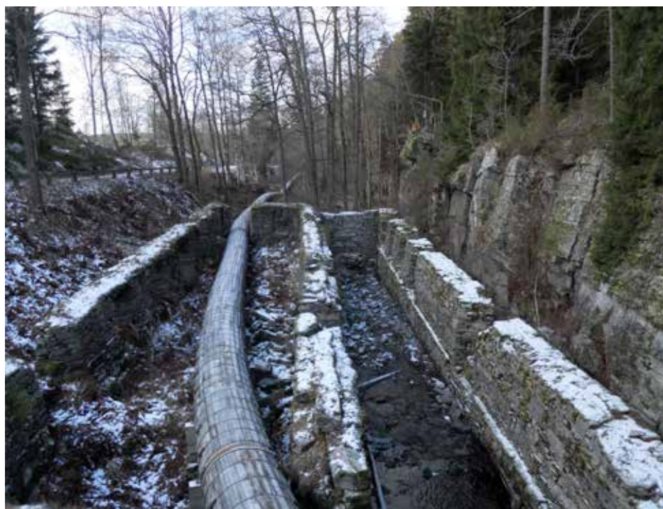
Vid Bäcke-fors kraftverk i Teåkersälven förs vattnet i en 500 meter lång tub från intagsdammen till turbinen. Här finns länets största population av flodpärlmussla som tyvärr minskar i antal. Flodpärlmusslan är beroende av öring för sin fortplantning. Öringen i sin tur är beroende av vatten.
