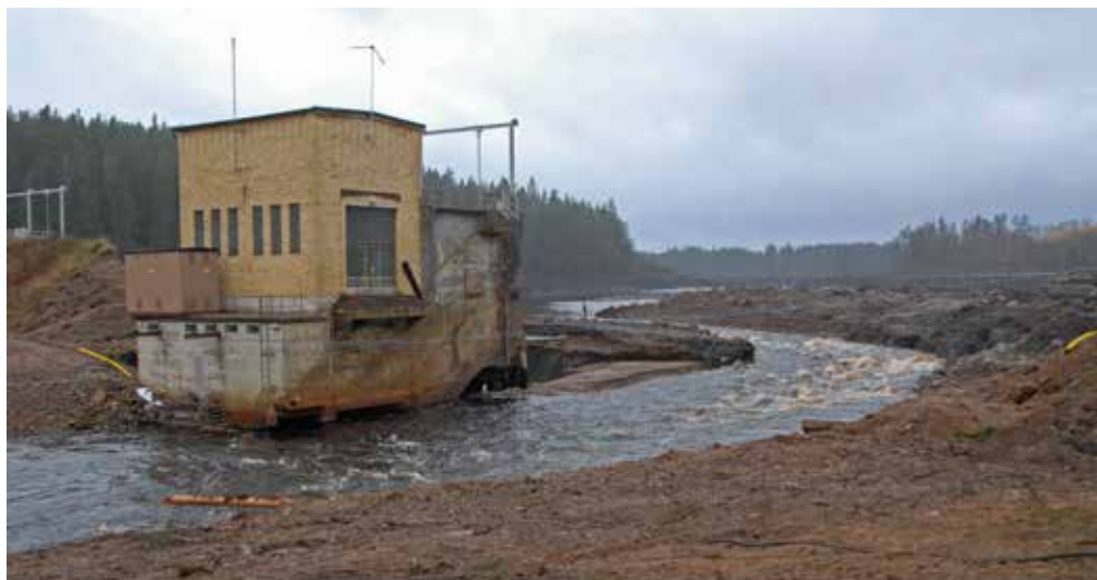
Hästberga kraftstation: Invigningen av kraftverket skedde 11 maj 1953, dammen rasade i 7 november 2010. Foto Mikael Svensson
