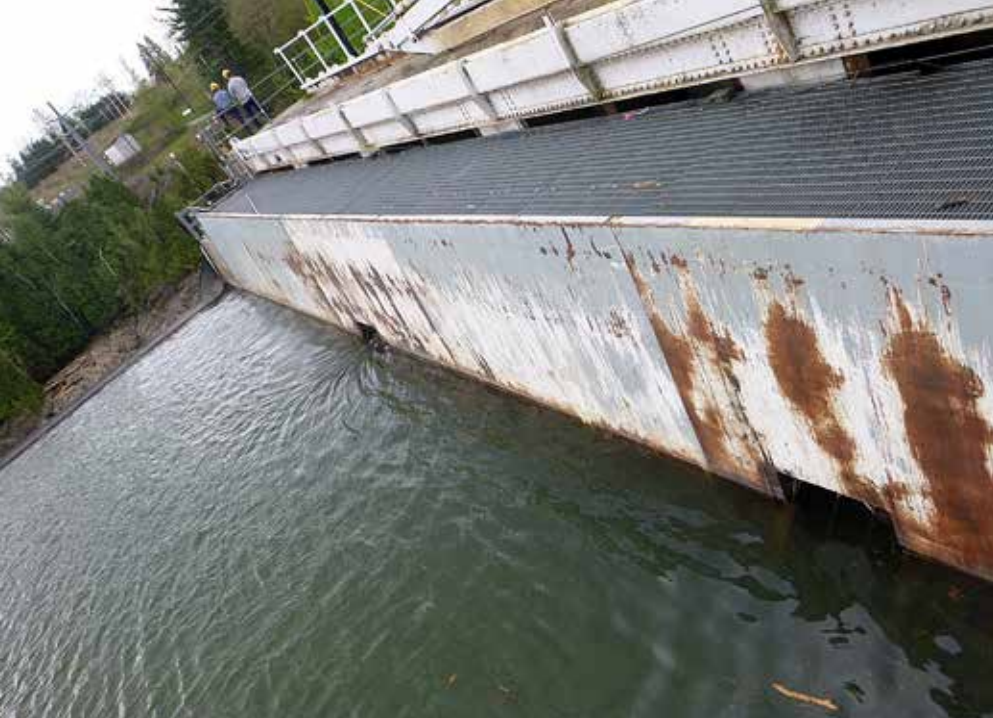
Bild till vänster: Bypass ingångarna vid ett av kraftverken i Winooski River. Under vattenytan finns ett intagsgaller som ska hindra fisk och skräp från att gå in i turbinerna. Trots gallret passerade flera fiskar via turbinerna. Dessutom överlevde flera fiskar inte bypass-passagen.
