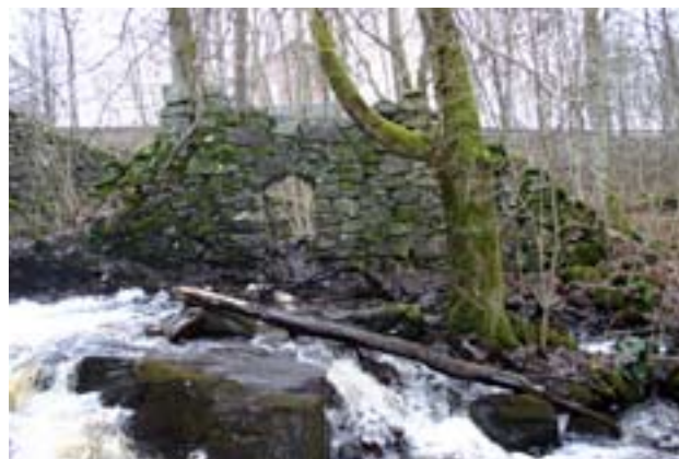
Figur 1. Hovgårdsdammen (till vänster i bild) och kvarnruinen från slutet av 1700-talet efter utrivning av en mindre del av dammen. Dammvallen har bevarats (uppe till vänster) liksom självfallet kvarnruinen nedströms. Kvarnruinen hotas dock att sprängas sönder av träd. Att ta bort träd och rötter försiktigt ökar ruinens "livslängd". Stenån, Hallands län. Plats: 634037-129951, karta 5 B NO Foto: Lars-Göran Pärklint, Fisk- och vattenvård.
