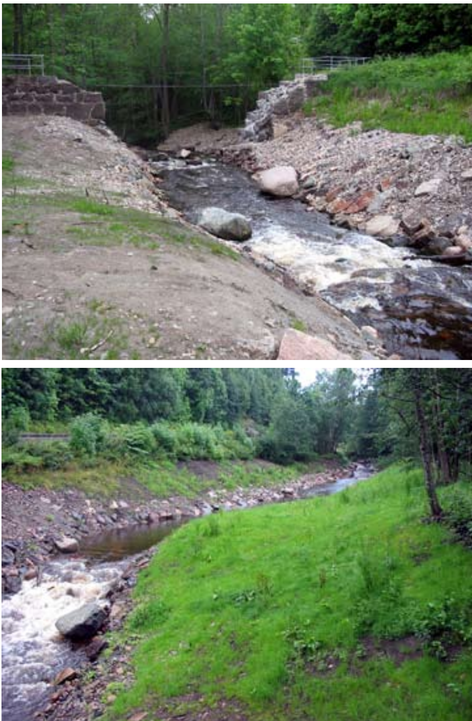
Figur 3. Hökhultsdammen efter utrivning. Efter utrivning blev ytterligare 1 km av Tabergsån tillgänglig för vandrande fisk, t.ex. insjööring från Vättern. Tätheten av öring har ökat från 5,2 till 140 per 100 m 2 två år efter åtgärd. Notera hur stränderna stenkläts för att minimera erosion. Genom stenutläggning i fåran har variation och mindre forsackar erhållits. Plats: 640033-139960, karta 7 D SO. Foto: Per Sjöstrand, Jönköpings fiskeribiologi.
