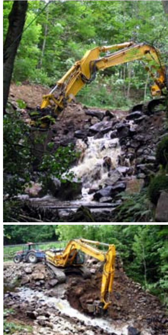
Figur 5. Utrivning av Hovgårdsdammen, Gåsslösa naturreservat, i Himleåns vattensystem, Varberg, Halland. Fallhöjden är ca 4 m och grävmaskinen arbetar ovanifrån på grund av svårframkomlig terräng nedströms. En fyrhjulsdriven traktor med dumperkärra transporterar bort massorna. Två sådana ekipage betjänade grävmaskinen för optimalt utnyttjande. Plats: 634037-129951, karta 5 B NO. Foto, nedre: Lars-Göran Pärklint, Fisk- och Vattenvård.
