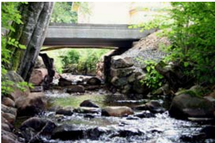
Figur 8. Utbyte av två dåligt placerade vägtrummor mot en håldäcksbro i Stenån, Varbergs kommun, Halland. Plats: 634079-129909, karta 5 B NO. Foto: Lars-Göran Pärklint, Fisk- och Vattenvård.
