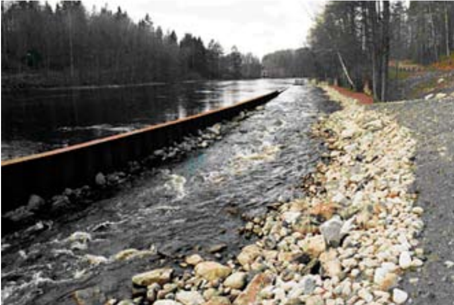
Figur 5. Hemsjö övre fiskväg anlagd som ett inlöp parallellt med Mörrumsån. Stålspont har körts ned i botten, s.k. Larssenspont som används i hamnar. Inlöpet fungerar också som extra utlopp vid högflöden då vattnet spiller över skiljeväggen. Observera att vattenföring vid låg- och normalvatten säkerställts med utskov, som syns i inlöpets övre del. Konstruktör: Mats Hebrand. Plats: 624586-143170, karta 3 E NO. Foto: Arne Johlander.
