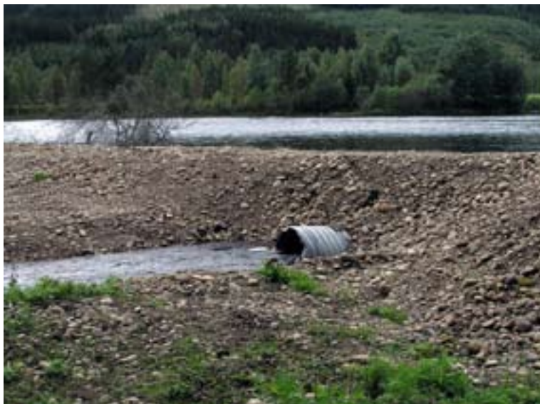
Figur 17. Genombrott igenom en flottledsavstängning i Klarälven. Genom att bibehålla styrarmen, ett kulturminne, och bara anlägga en trumma har både kulturmiljövårdens och naturvårdens intressen tillgodosetts.
