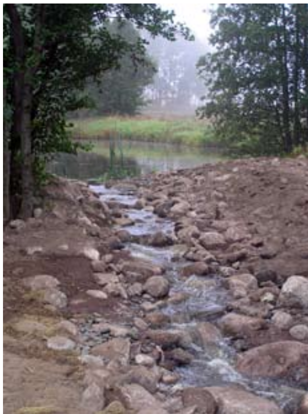
Figur 4. Upptrösklingen i Sjörydsbäcken, Hjo kommun, ger ett stryk med v-formad bottenprofil för att fungera såväl vid låg som hög vattenföring. Fotot är taget under konstruktion och marktäcke m.m. är ännu ej på plats. Botten har tätats med fint material. Konstruktör: Robert Versa, Ignita. Plats: 646681-141089, karta 8 E SV.
