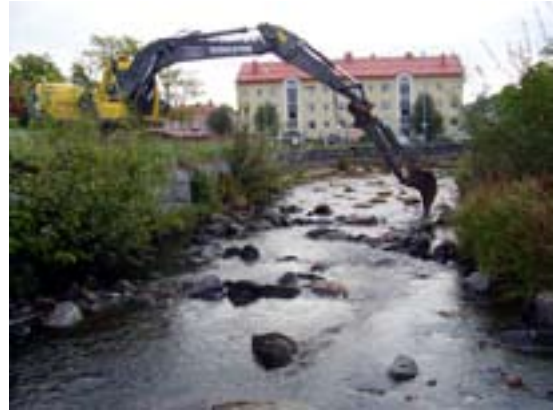
Figur 3. Grävmaskiner kan vid behov förlänga armen ("stickan") för att kunna arbeta i bredare vatten eller i områden som är svåra att nå. Observera att alltid kontrollera att maskinen är besiktigad för att använda förlängd arm. Foto: Peter Hallgren, Söderhamns kommun.
