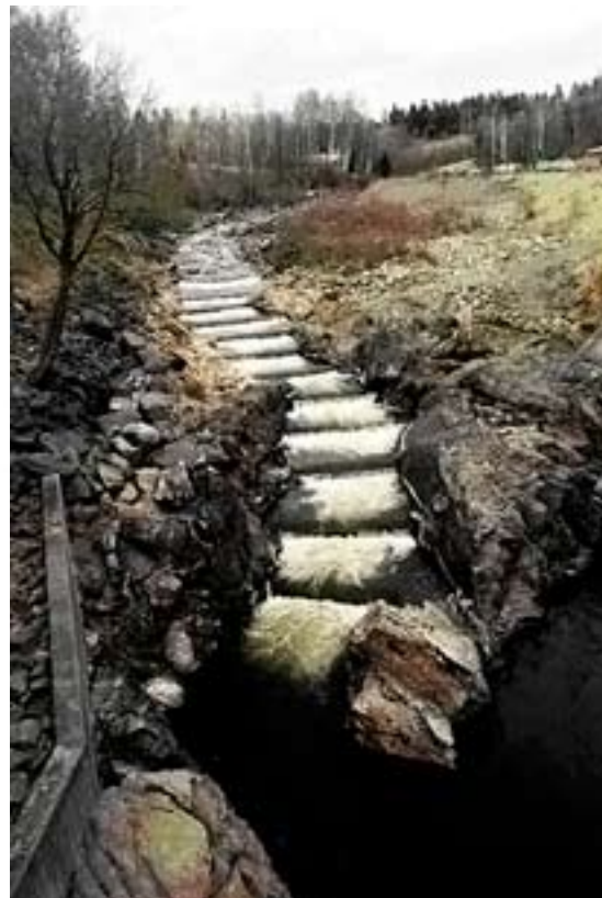
Figur 14. Kammartrappan i Gullspångsälvens nedre del förbinder nedre habitat med den gamla torrfåran som numera har vatten. På grund av hög lutning, men ringa vattenståndsvariationer har man valt att bygga en kammartrappa. Flödet genom trappan är 3 \text{ m}^3/\text{s} . Konstruktör: Lars Pettersson, Mats Hebrand. Plats: 654183-140238, karta 9 E NV. Foto: Arne Johlander.
