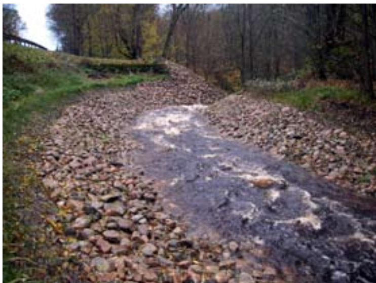
Figur 6. Resultat efter utrivning av Hovgårdsdammen. Observera att muren sparats (syns i bildens vänstra del). Vattendragets botten har stensatts (s.k. stensula; natursten 120–500 mm i ca 0,7 m tjockt lager) för att inte erodera ned i de gamla sedimenten från dammen. Sedan har några större stenar lagts i för skapa habitatvariation och minska vattenhastigheten. Foto: Lars-Göran Pärklint, Fisk- och Vattenvård.
