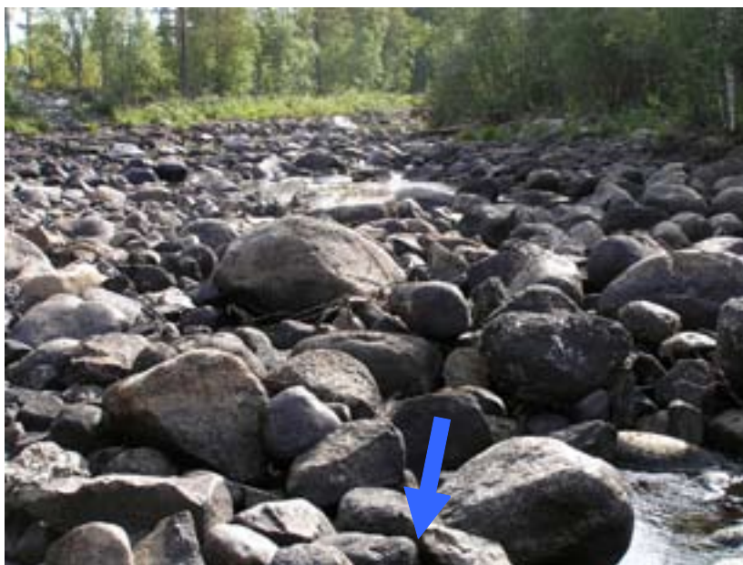
Figur 11. Restaurerad sträcka av Gargån, Västerbotten, vid extremt lågvatten. Det är viktigt att tätta bottenarna som byggs upp. Mycket av det fina materialet har i regel spolats nedströms och man saknar "tättningsmaterial". Den sten man lägger tillbaka kommer därmed att ligga ovanpå varandra utan kitt emellan. Vid lågvatten kan detta göra att vattnet rinner under stenarna. Ganska snart kommer dock dessa bottenar att tätas naturligt.
