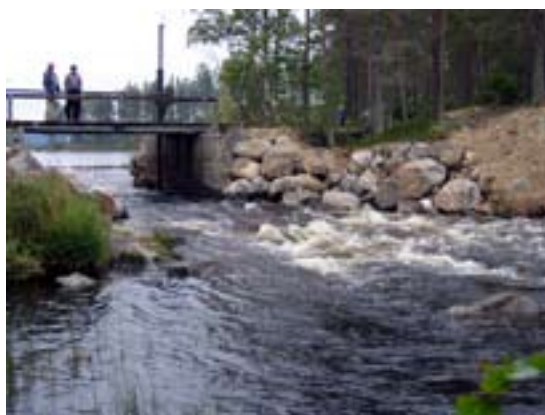
Figur 8. Utrivning av dämme vid Lillsävarträsk utlopp, Sävarån, Västerbotten. Dammtröskeln (vänster bild) har tagits bort och en lätt passerbar tröskel har byggts upp (höger bild). Dämmets fundament finns kvar dels för att stabilisera utloppet, dels av kulturvårdsskäl. Genom tröskeln erhålls samma vattenyta i Lillsävarträsk. Plats: 714319-170758, karta 21 K NV. Foto Före: Mats Norberg, Efter: Per Kroon, båda länsstyrelsen i Västerbottens län.
