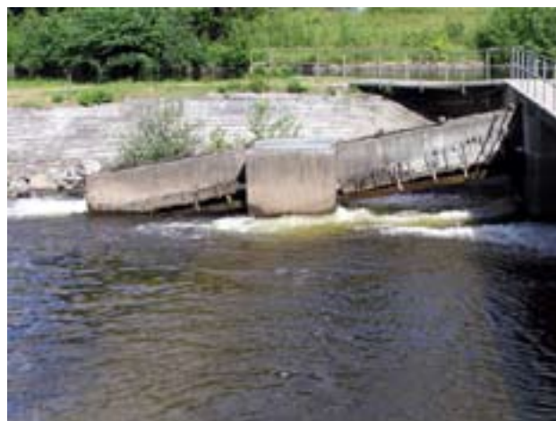
Figur 23. En fiskväg i form av en denilrännan vid Aspens utlopp i Sävåen, Västra Götalands län. Observera hur extra lockvatten från Aspendammen styrs mot fiskvägen. Utanpå denilrännan sitter en älledare av trä fäst. Älen har inte samma krav på hög vattenström som laxfisk, varför älledarens placering är tveksam. Plats: 640865-128450, karta 7 B SO.
