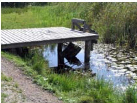
Figur 13. Överfallsbrunnar av olika typ i anlagda våtmarker, Oset, Örebro kommun.
