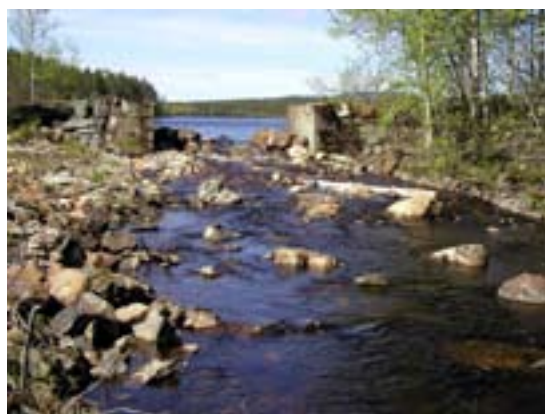
Figur 7. Utloppsdämme vid Storsjön; Strömbäcken i Lögdeälven. Den tidigare flötningsdammens dammtröskel, skibord och sättare har tagits bort (vänster bild). Istället har en naturlig stentröskel etablerats (höger bild). Man kan lämna ännu kvar mer av de tidigare dammstrukturerna utan att påverka. Observera dock att fundamenten innebär att sjöns däm vid höglöden. Plats: 708670-163790, karta 20 I NO. Foto Roger Vallin, Länsstyrelsen i Västerbotten.
