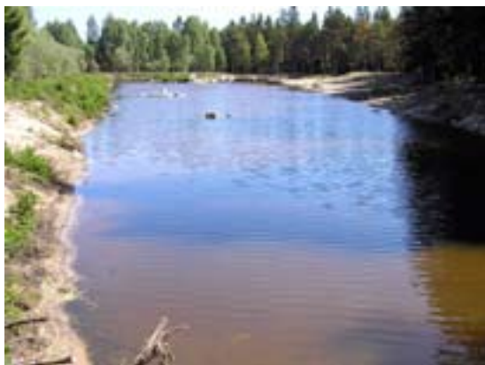
Figur 4. Nyanlagt viltvatten på Gotland som också fungerar som fångdamm. Inloppet sker i dammens övre vänstra del och utlopp under fotografen. Vatten leds in från bäcken och leds tillbaka 125 m nedströms
