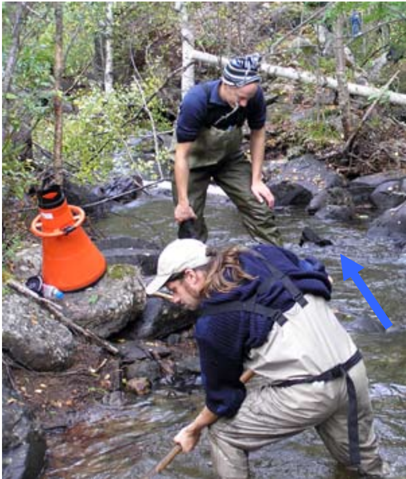
Figur 3. Etablering av lekbotten enligt Hartijokkimetoden. Uppströms grävs och sällas lekgrus fram och läggs sedan precis nedom forsacken nedströms. Vid forsacken har ett antal större stenar/block lagts för att hålla kvar lekgruset. Joel Berglund i bakgrunden står på dessa stenar/block.
