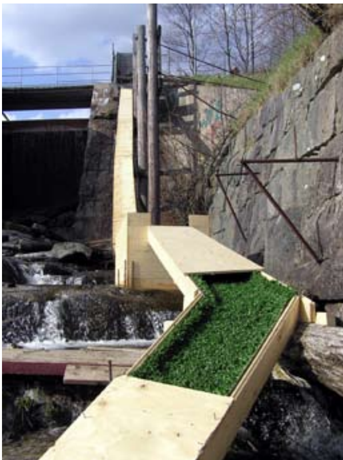
Figur 21. Undersökningar av uppvandrande ål vid Hedefors, Sävån, visade att många missade ålledaren och istället lockades till dammen av spillvatten (Larsson 2006). Där försökte de ta sig upp för 6 meter lodrät dammvall. Foto och undersökning Stefan Larsson, West waters.
