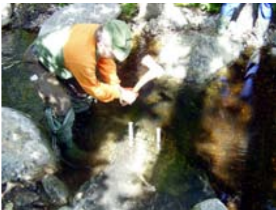
Figur 10. Behöver man av någon anledning spräcka sten, som här i Tvärån för att förbättra en faunapassage, går det bra med kilar och handkraft. För att borra hål i sten fungerar en s.k. bergborr. Foto: Peter Hallgren, Söderhamns kommun.
