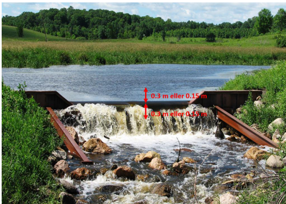
Figur 10: Illustration av dämme med undre och övre magasin. DHI, 2018. Bildkälla okänd.
