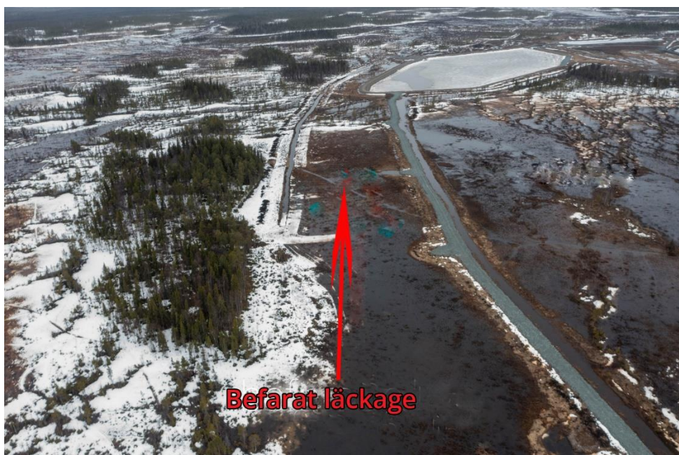
Figur 5 Samma läckage enligt Figur 6, 2 veckor senare
