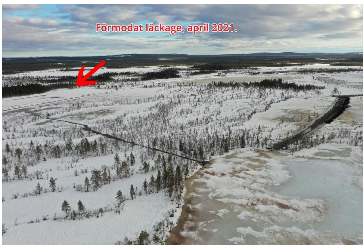
Figur 4 Förmodat läckage april 2021
