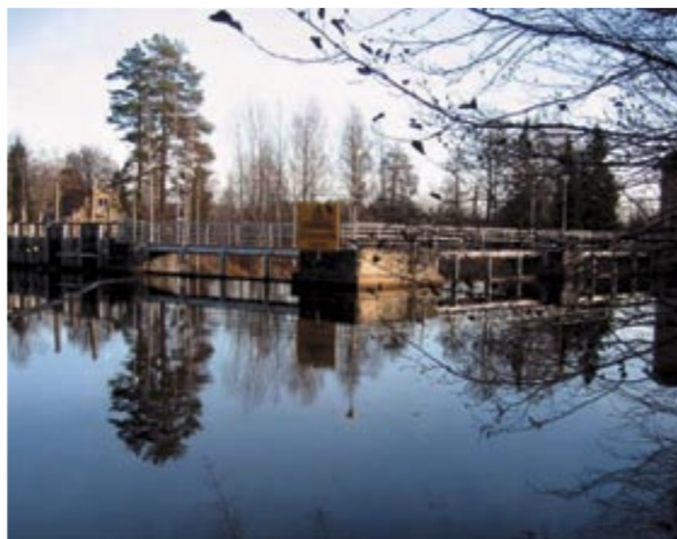
Bild 1a. Forsby damm i Testeboån norr om Gävle var ett strömfallskraftverk från 1926 med ca 4 meters fallhöjd.
