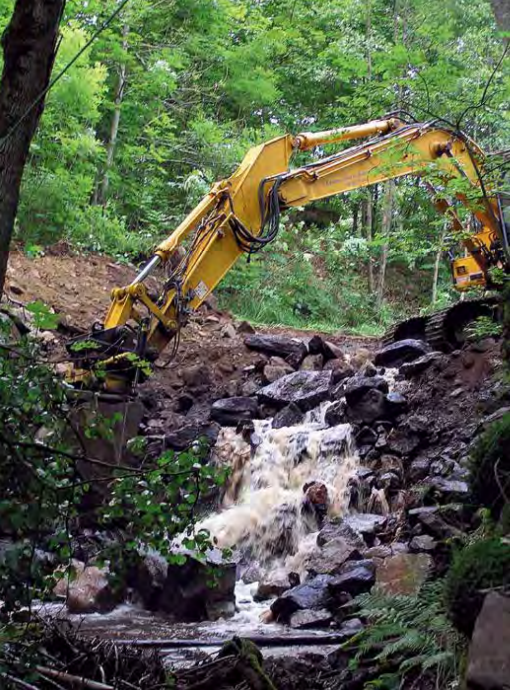
Utrivning av dammen i Stenån, ett av Himleåns många biflöden, öppnade upp flera hektar nya uppväxtområden för lax, ål och havsöring och samtidigt blev det åter strömmande vatten i områden som förvandlats till stilla vatten.
