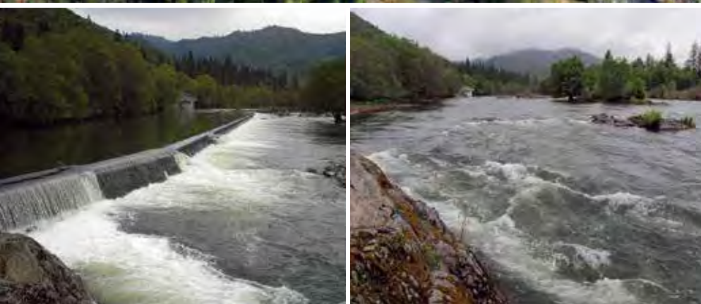
Övre bild : Dammen Gold Hill. Undre bilder: Före och efter rivningen
