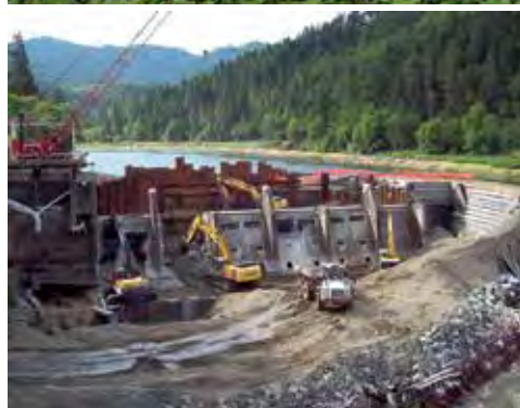
Övre bild: Dammen Savage rapids. En fångvall anläggs på flodens högra sida så att delar av dammen torrlägg.
