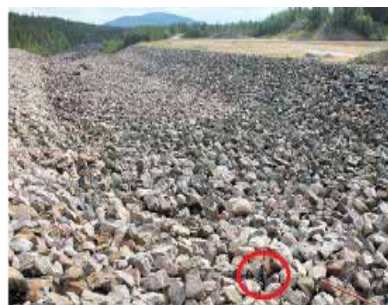
Letsi sett nedströms, 17 km torrlagd älvfåra. För skala, se inringad Kurt Lundström som vandrar i torrfåran. Foto Roland Boman, bearbetning Siri Lundström.
