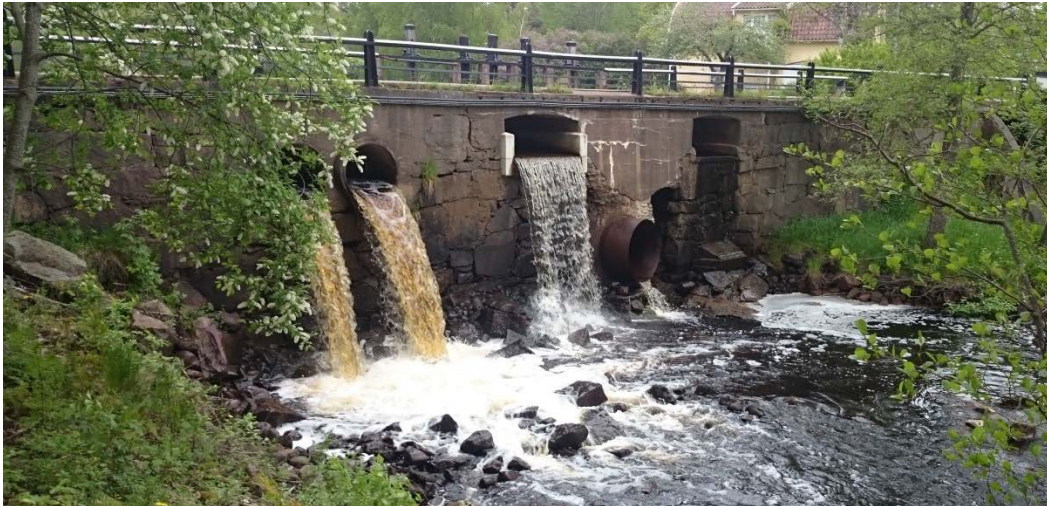
Figur 1. Nedströmssidan av en damm eller dammvall/dammbyggnad/dammfäste i Emåns vattensystem.
