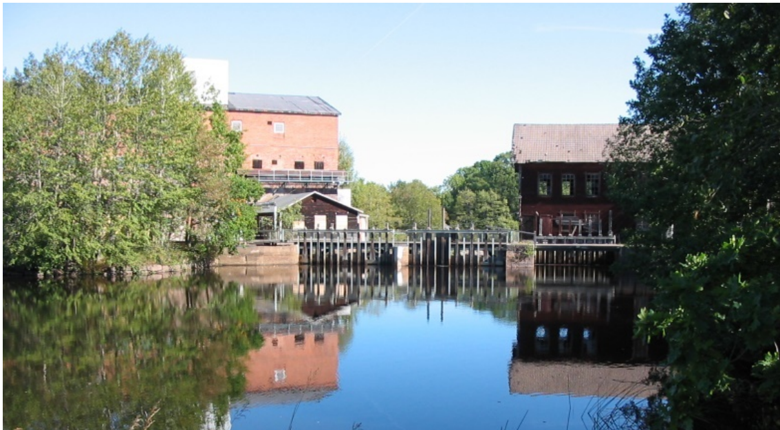
Figur 12. Före avsänkning och utrivning i september 2003.
