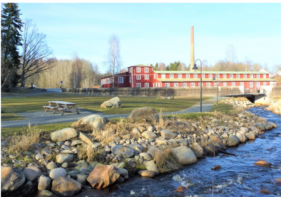
Figur 10. Efter utrivningen 2010 med färdig park på gamla sediment.
