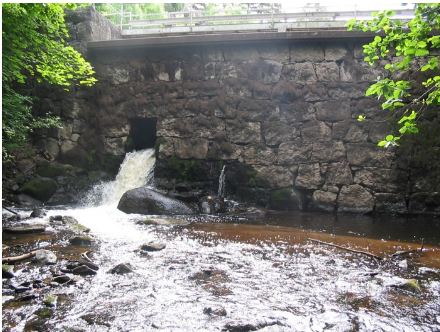
Figur 6. Före utrivning: Hökhultsdammen i juni 2004, avsänkt via bottenluckan.
