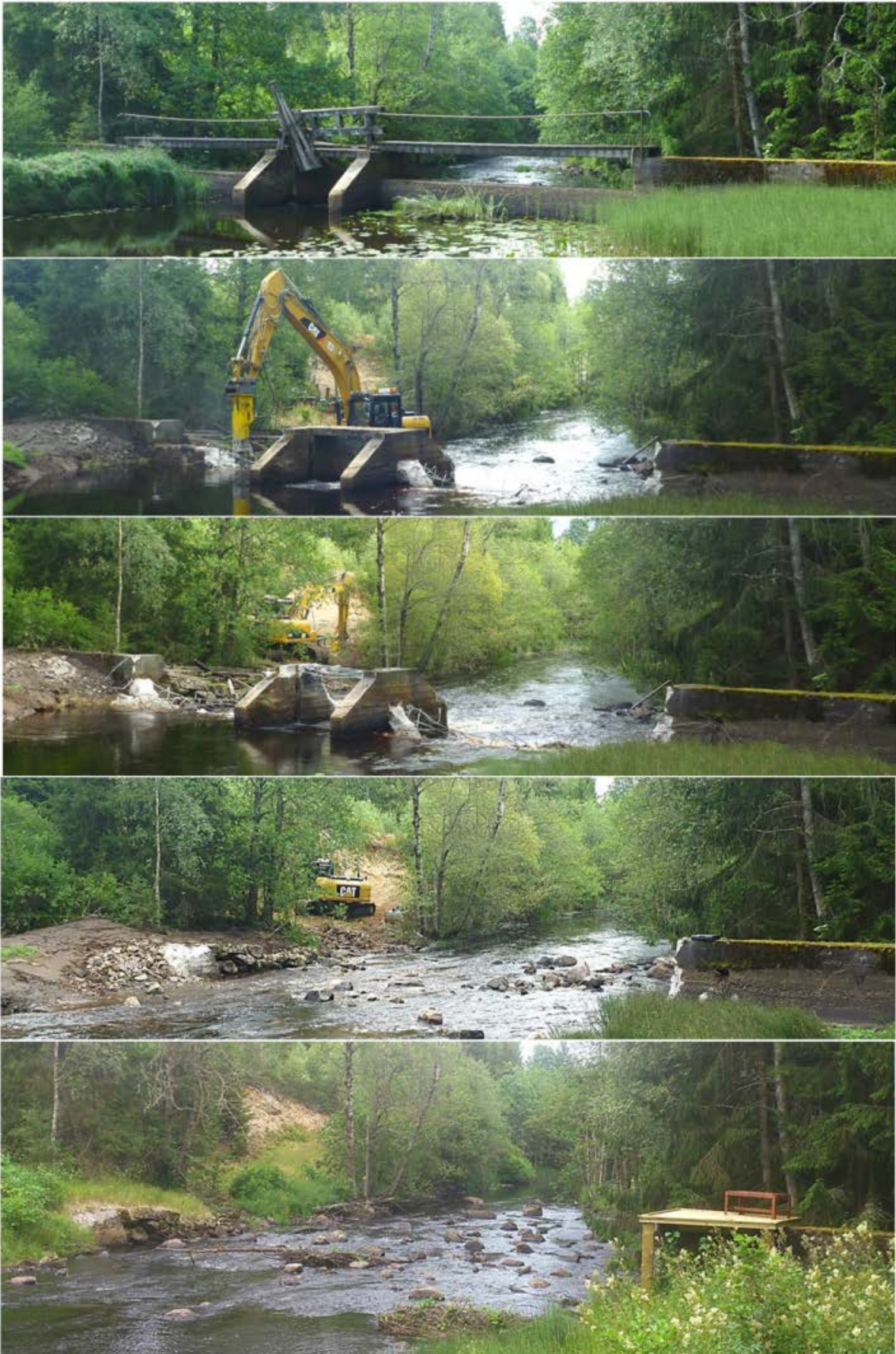
Figur 16. Bildserie över utrivningen av dammen i Timmershult. Från 2 år före utrivning till 5 år efter.
