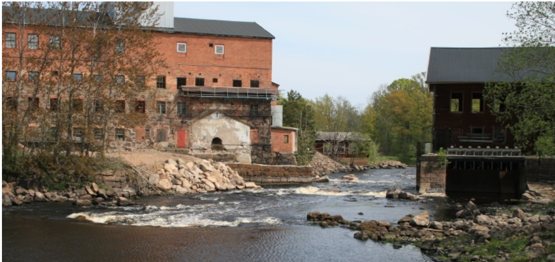
Figur 14. Efter utrivning av damm och kraftverk i maj 2011.
