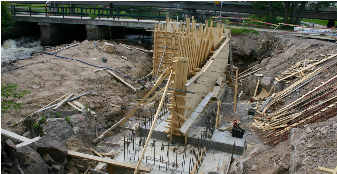
När man bygger fiskvägar behövs ofta mycket byggnadsmaterial. Att ta fram det betyder arbetstillfällen i byggsektorn. Här byggs en denilränna i Svartån i Tranås. Foto: Lennart Gustavsson
