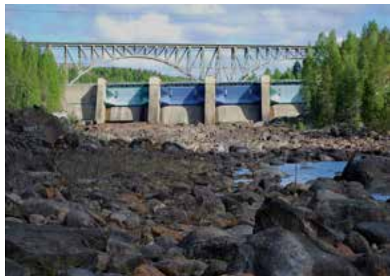
Forsmo kraftverk efter regleringen.
