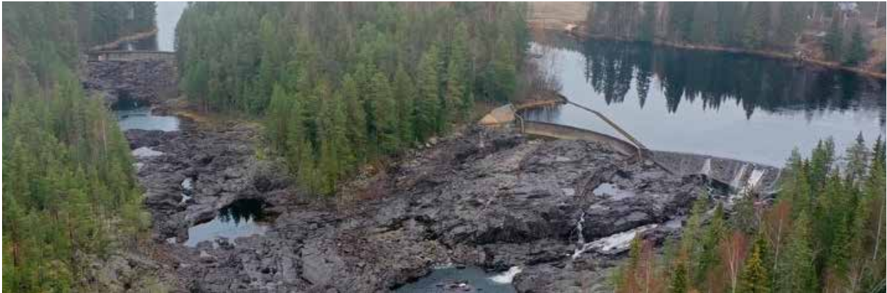
Holaforsen som ligger väster om byn Näsåker före och efter regleringen..
