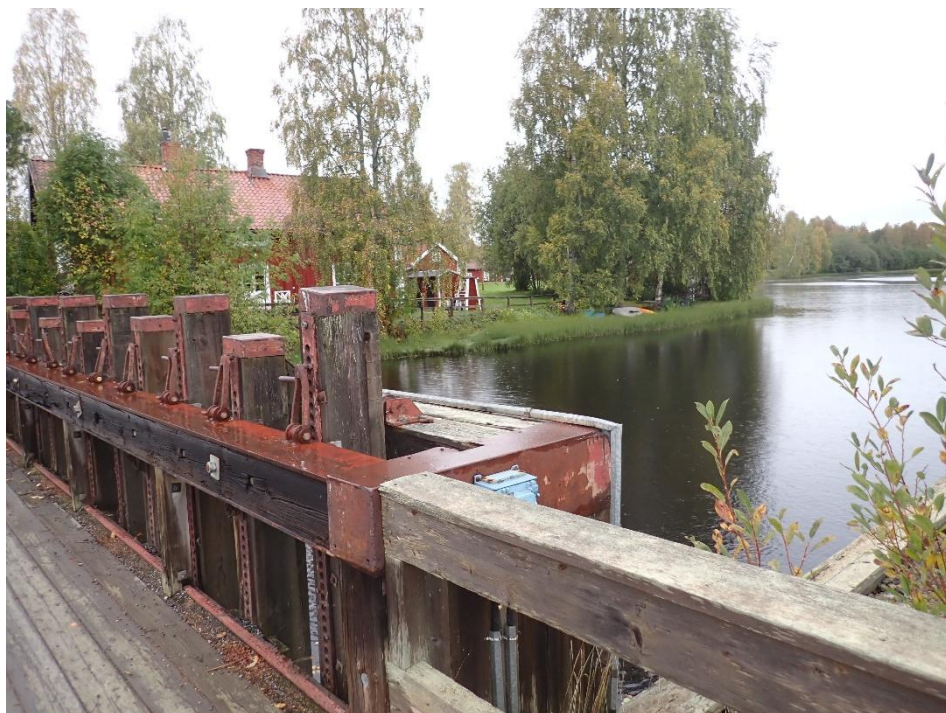
Vy från vägbron uppströms mot höger strand och bostadshus, vattenspiegel uppströms kraftverket/-n.
