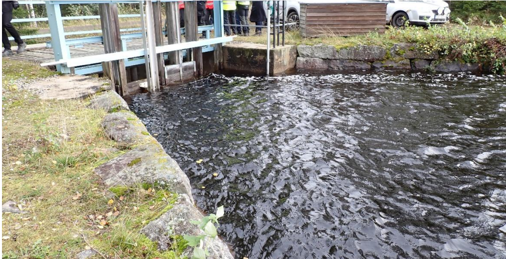
Uppströms regleringsdammen, stenmurar längs stränderna.
