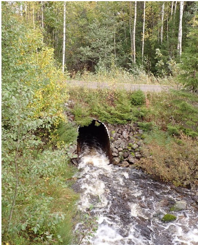
Trumma under vägen, nedströms regleringsdammen.
