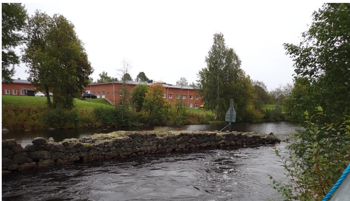
Kallmurad stenmur/ledarm nedströms kraftverksdammen.
