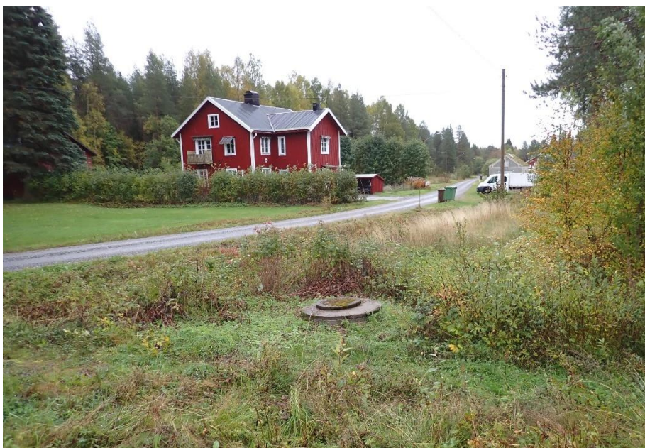
Avloppsbrunn nedströms dammvallen på vänster sida.
