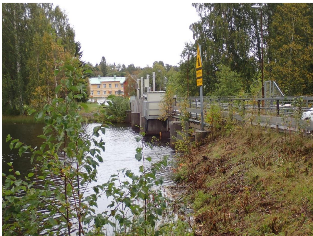
Uppströms kraftverksdammen, brostöd och vägbro.
