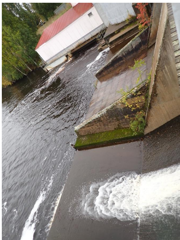
Skiborden i betong eller plåt på nedströmssidan bron.
