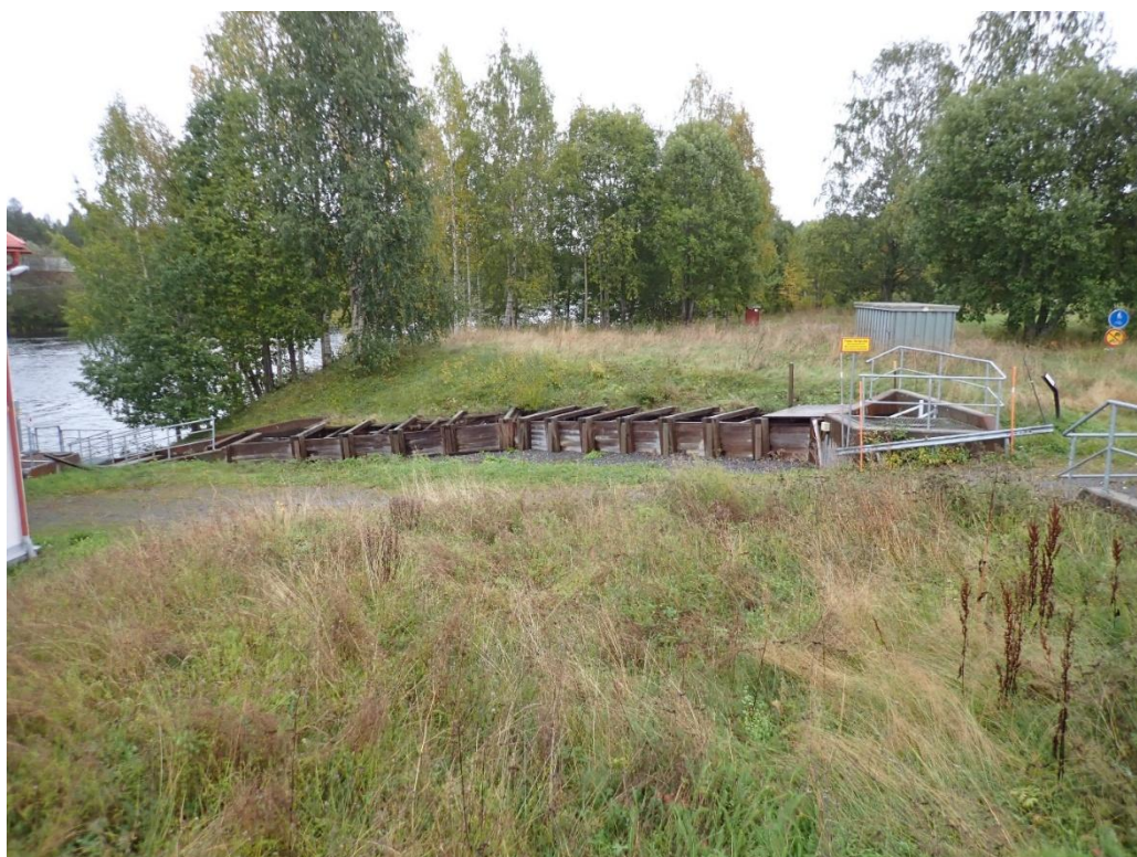
Fisktrappan, vars nedre del är av trä och den övre i betong.
