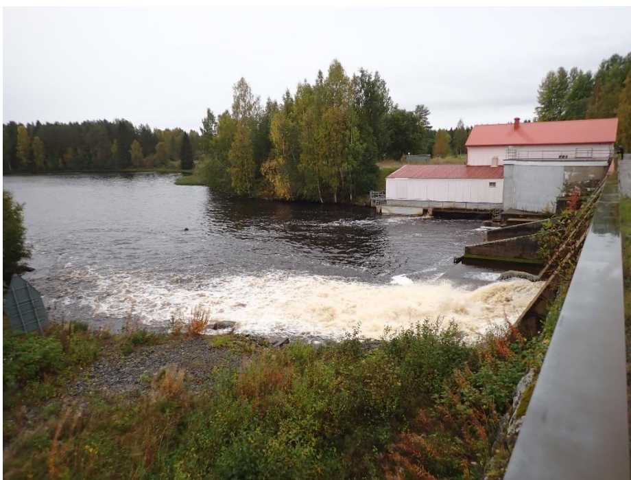
Vänster utskov öppet, kraftverket står stilla vid fototillfället, vid kraftverket syns utlopp från fisktrappan.
