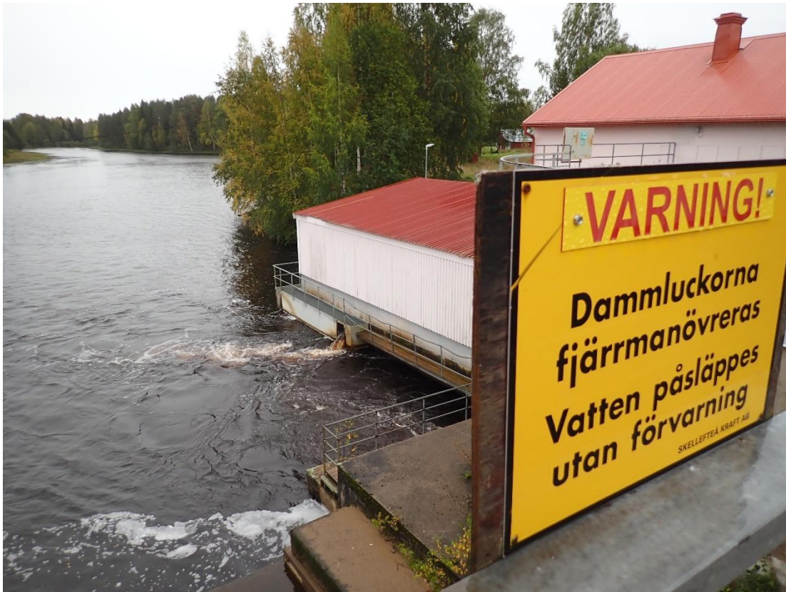
Vy från vägbron över höger sida med kraftverket och fisktrappans utlopp.
