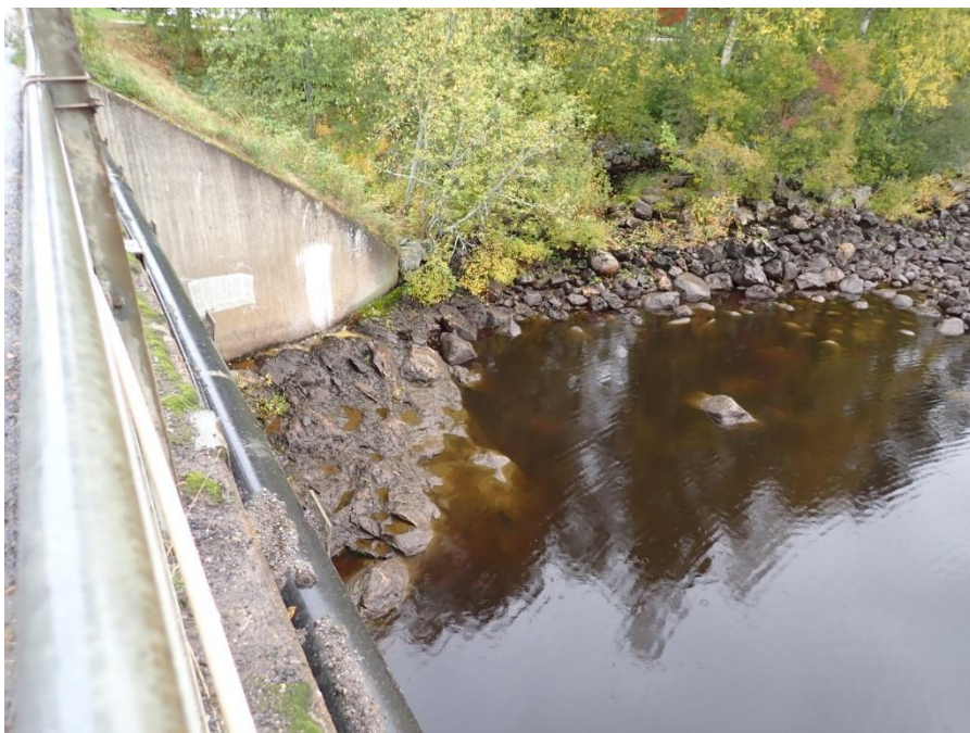
Vänster strand, nedströms bron, gjuten brokona i betong på berghäll.
