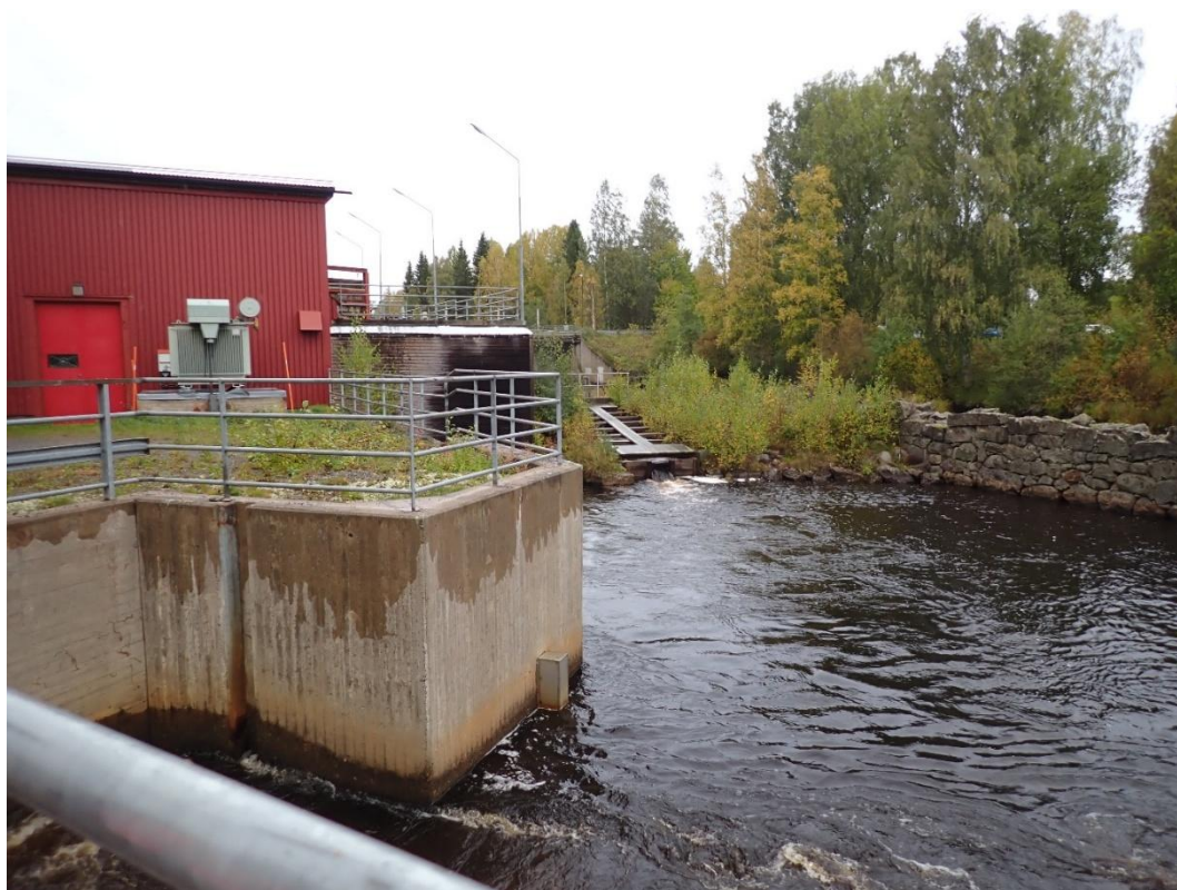
Utlöpp från kraftverket till vänster i bild, insteg till fisktrappan i mitten av bilden, stenmuren till höger i bild.
