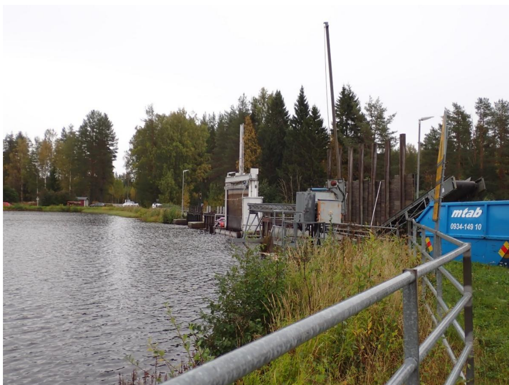
Vy från höger strand uppströms dammarna, utskoven och vägbron.
