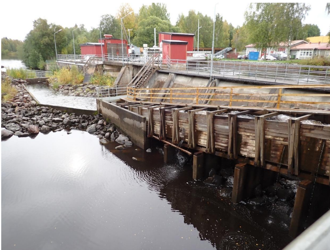
Vy från vägbron över fisktrappan och kraftverket.
