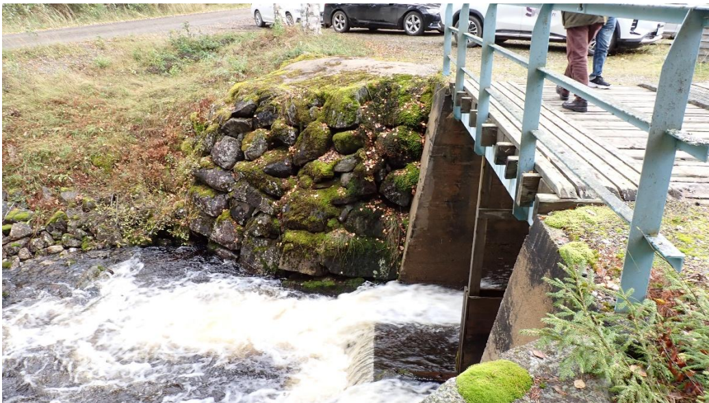
Stenmur på höger strand nedströms dammen.
