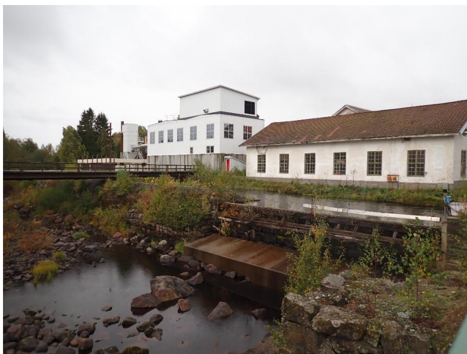
Vy från vägbron ner mot höger sida av ån, ledarm och intagsfåran till gamla kraftverket, Norrländsgjuteriet.
