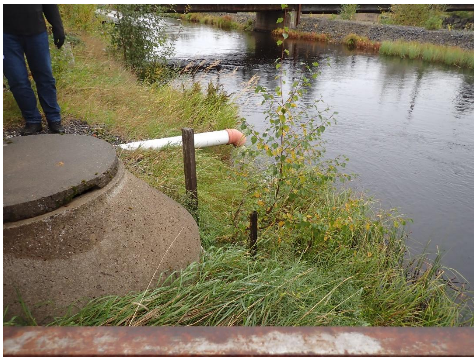
Höger strand med kylvattenintag och utlopp från Norrlandsgjuteriet.
