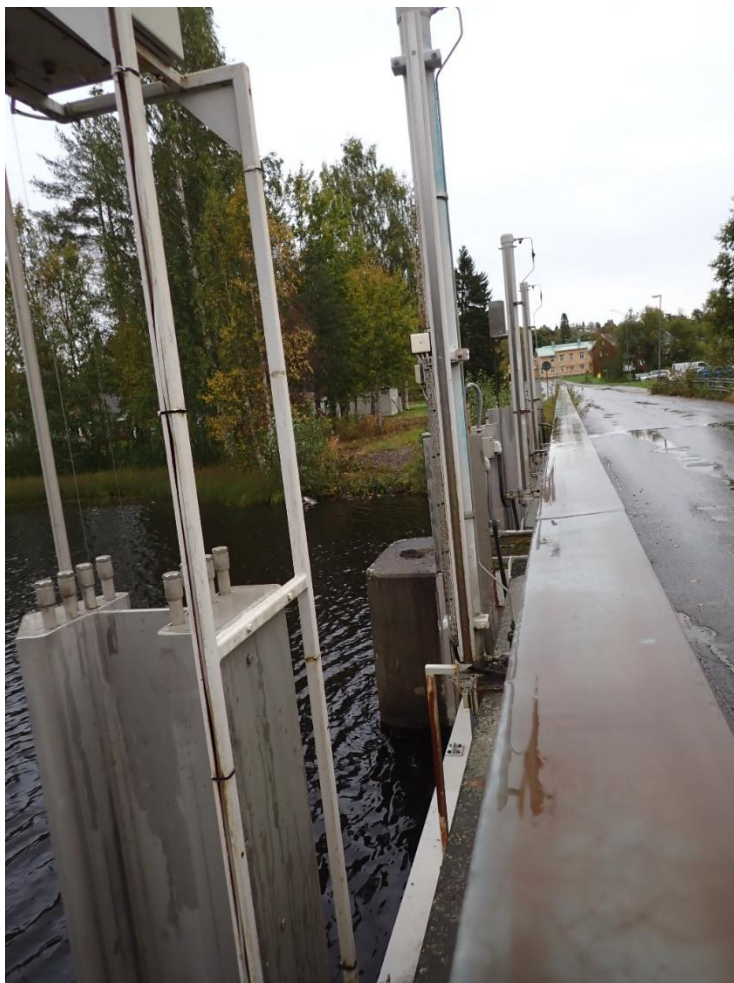
Asfalterad vägbro och manöveranordningar för utskoven.
