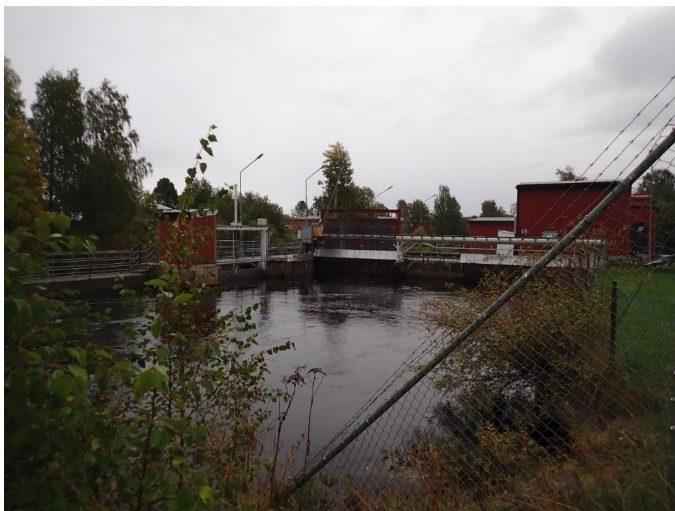
Vy från höger strand, intag till kraftverket.
