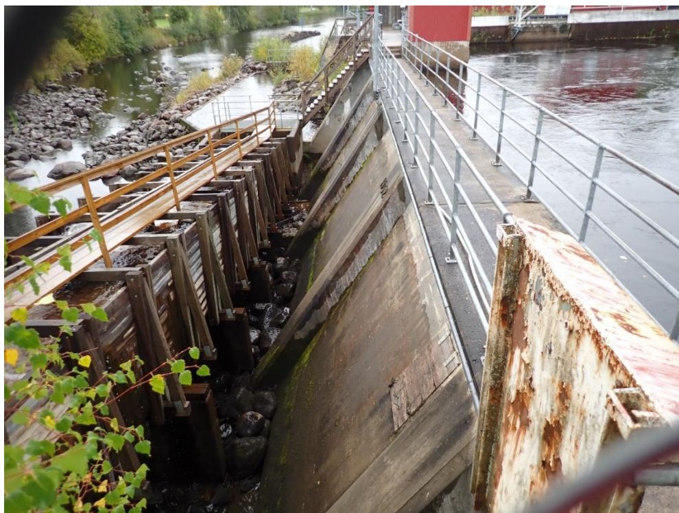
Fisktrappa till vänster, intag till kraftverket till höger.
