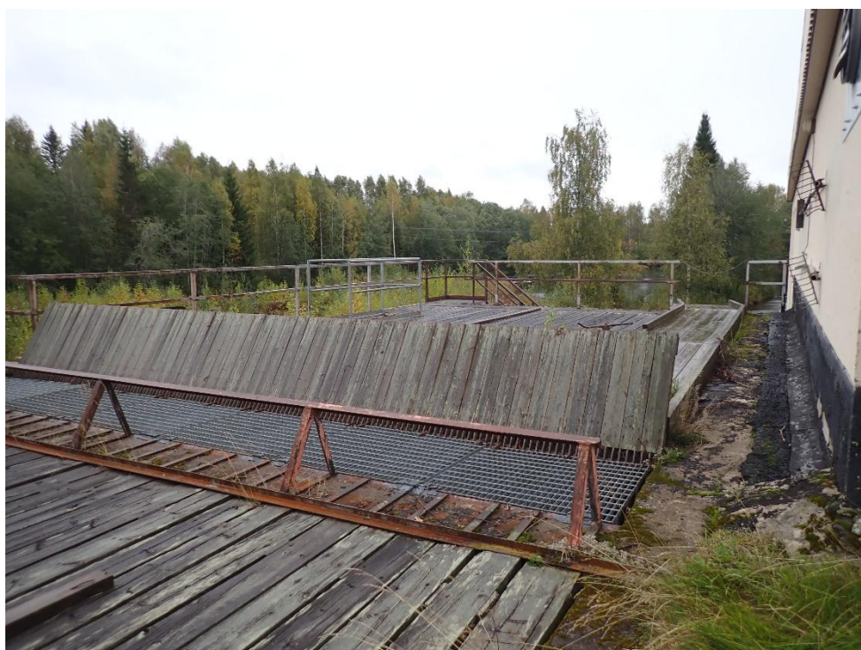
Vy från höger strand över tak till gamla kraftverket.
