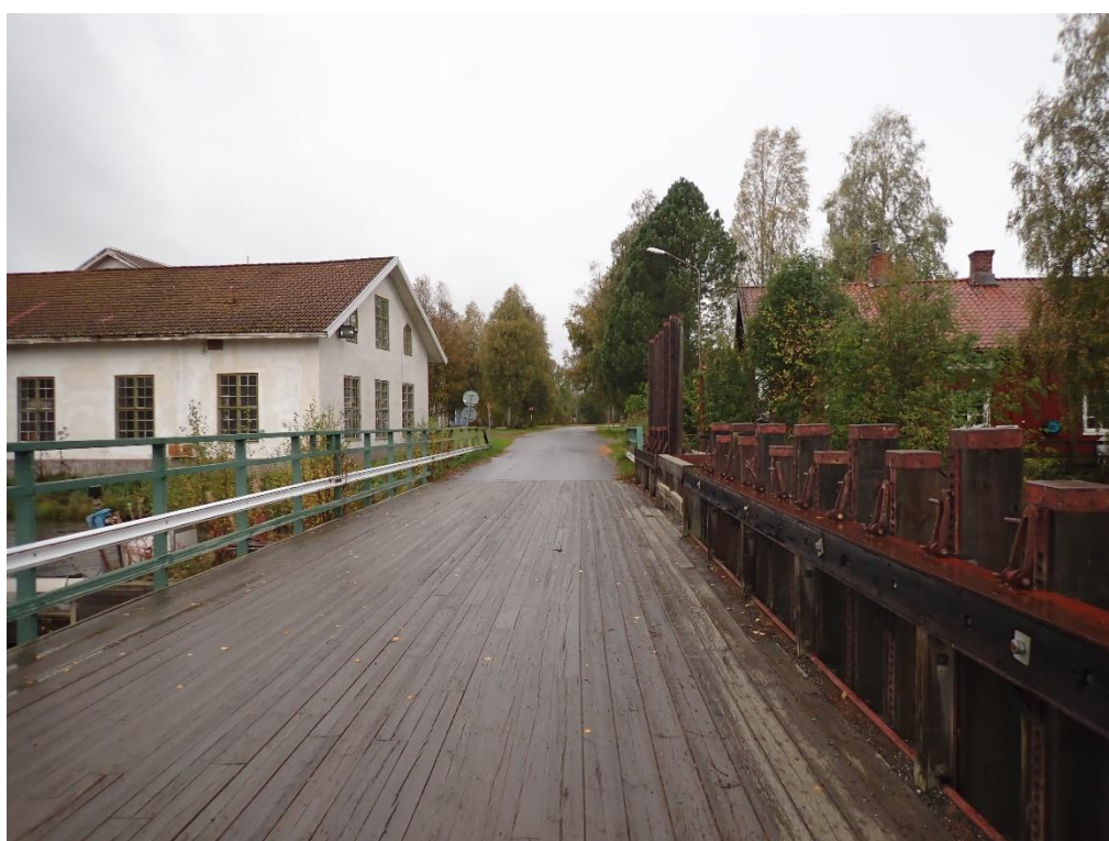
Vy från vägbron åt höger strand, utskov med manöveranordningar till höger i bild.
