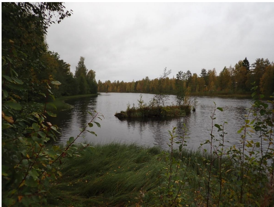
Uppströms kraftverksdammen, vy från högra stranden.
