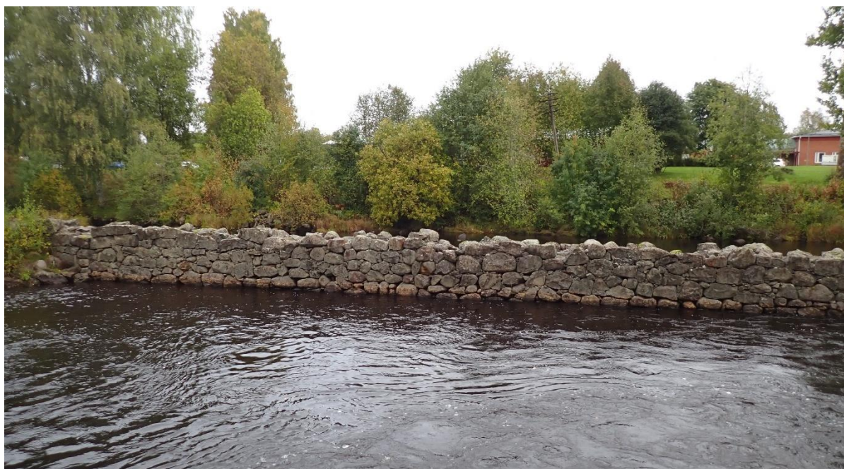
Kallmurad stenmur/ledarm nedströms kraftverksdammen.
