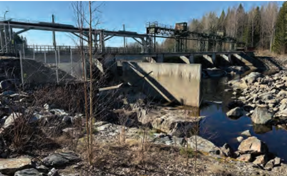
Dammarna vid Lanforsens kraftverk behöver ersättas av naturliga forsackar som reglerar strandlinjen i Marmafjärden och Storfjärden.
