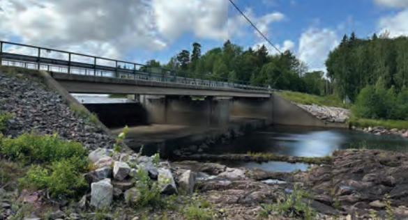
Alla dammar vid Söderfors kraftverk måste avvecklas till förmån för fritt strömmande vatten i Bredforsen.
